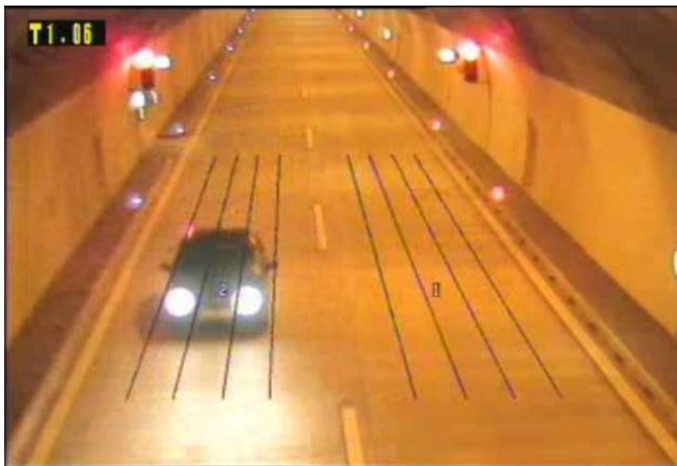
Slika 11.6.2: Automatski uređaji u tunelu su registrovali vozilo koje se kreće u pogrešnom smeru; na semaforima i portalu tunela su upaljena crvena svetla
