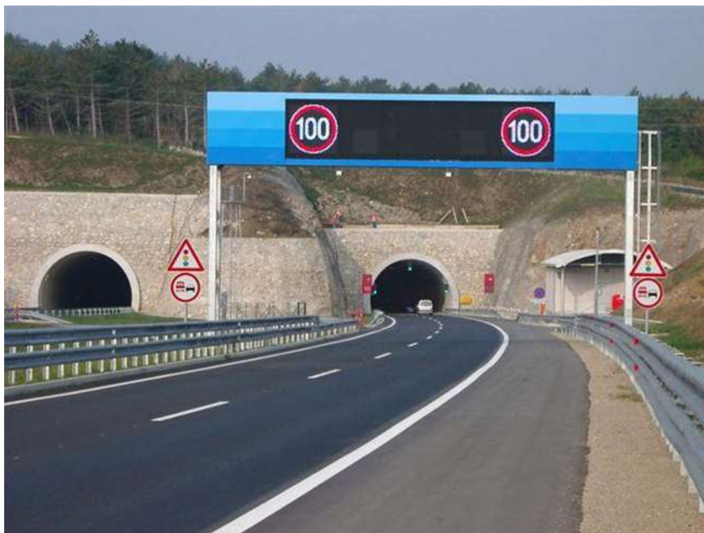
Slika 11.6.6: Portal tunela i uređaji za vođenje saobraćaja
