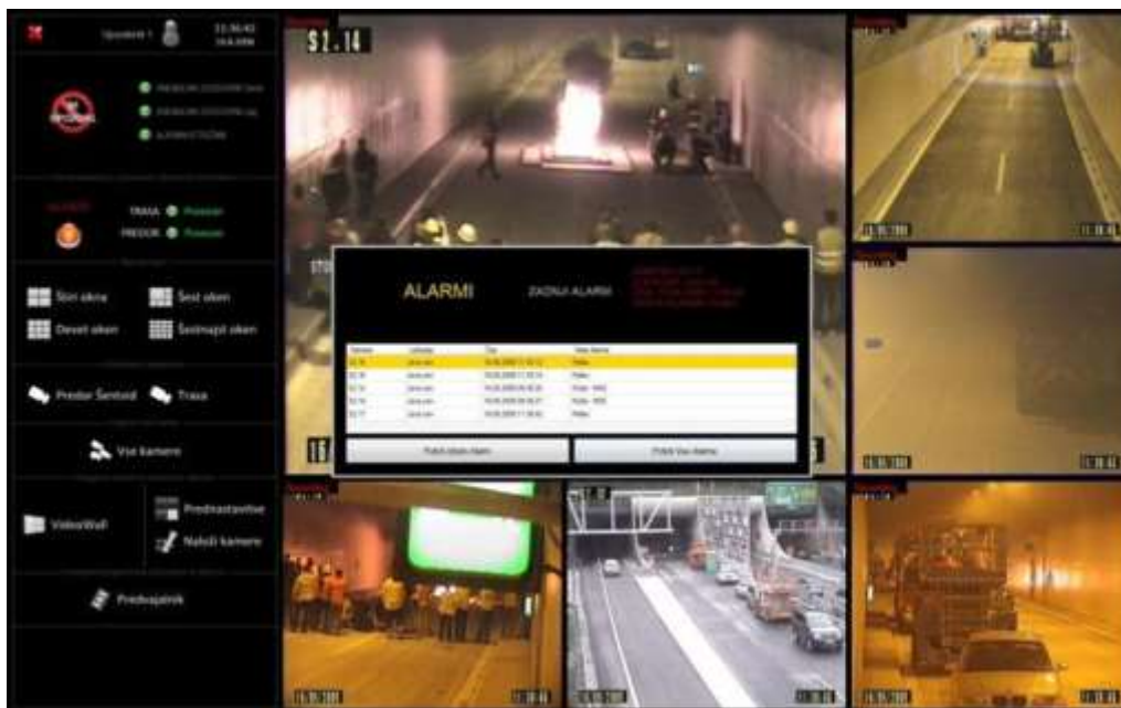
Slika 11.6.5: Ispis podataka o javljenim alarmima na VNS aplikacijinadzor saobraćaja VNS,
