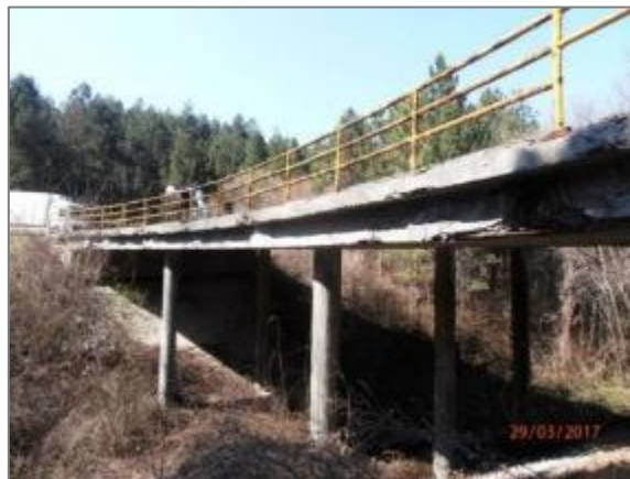
Слика 40 - Мост преко потока (Мрчића мост)
