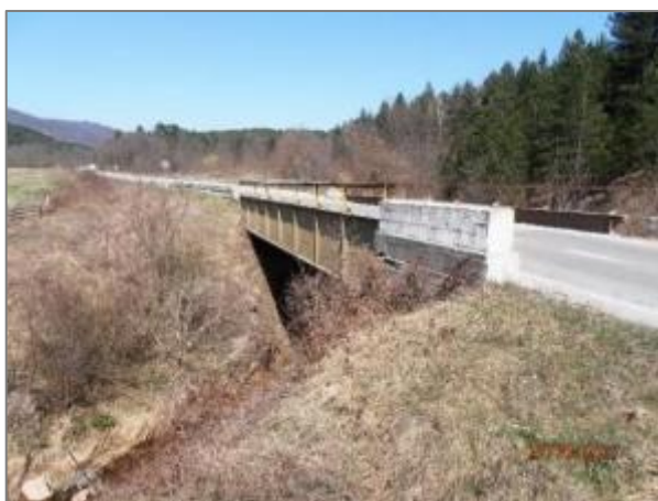
Слика 41 - Мост преко потока у Марковићима
