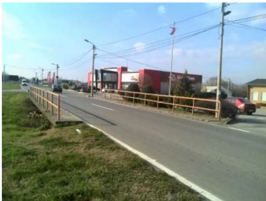
Слика 6. Мост у Свилајнцу
