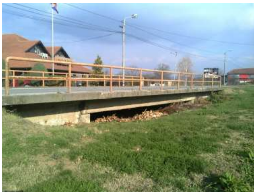
Слика 7. Мост у Свилајнцу
