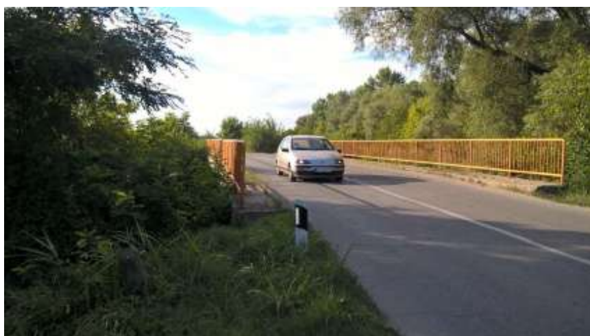
Слика 5. Мост преко реке Раче.
