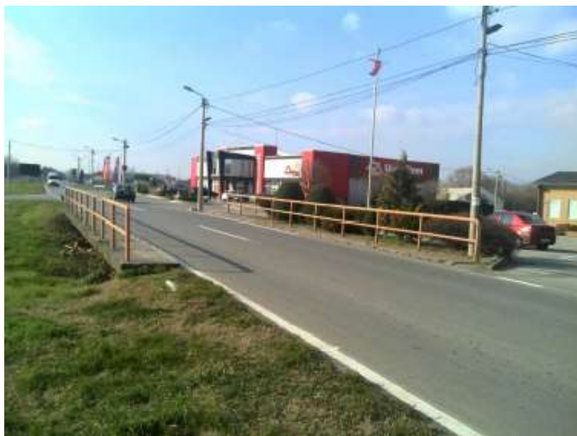
Слика 15. Мост у Свилајнцу
