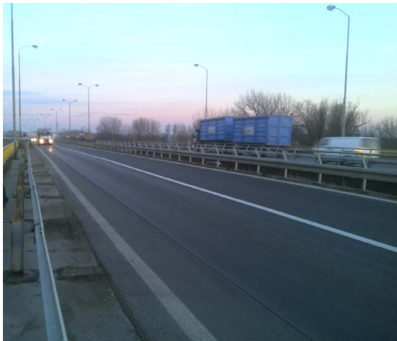
Слика 5. Мост на левој траци
