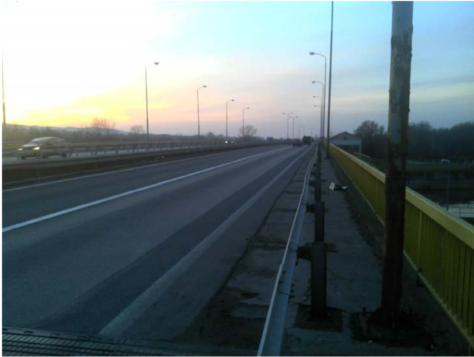
Слика 4. Мост на десној траци
