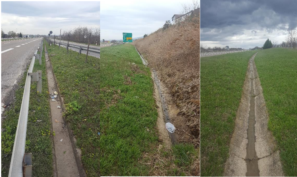
Слика 9. Бетонски канали на предметној деоници
