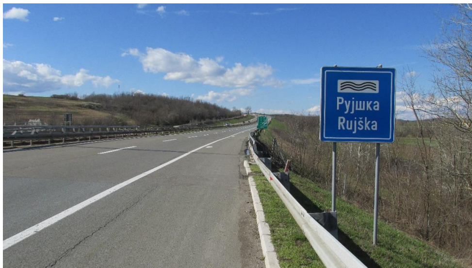
Слика 18. Мост преко реке Рујшка на км 392+249
