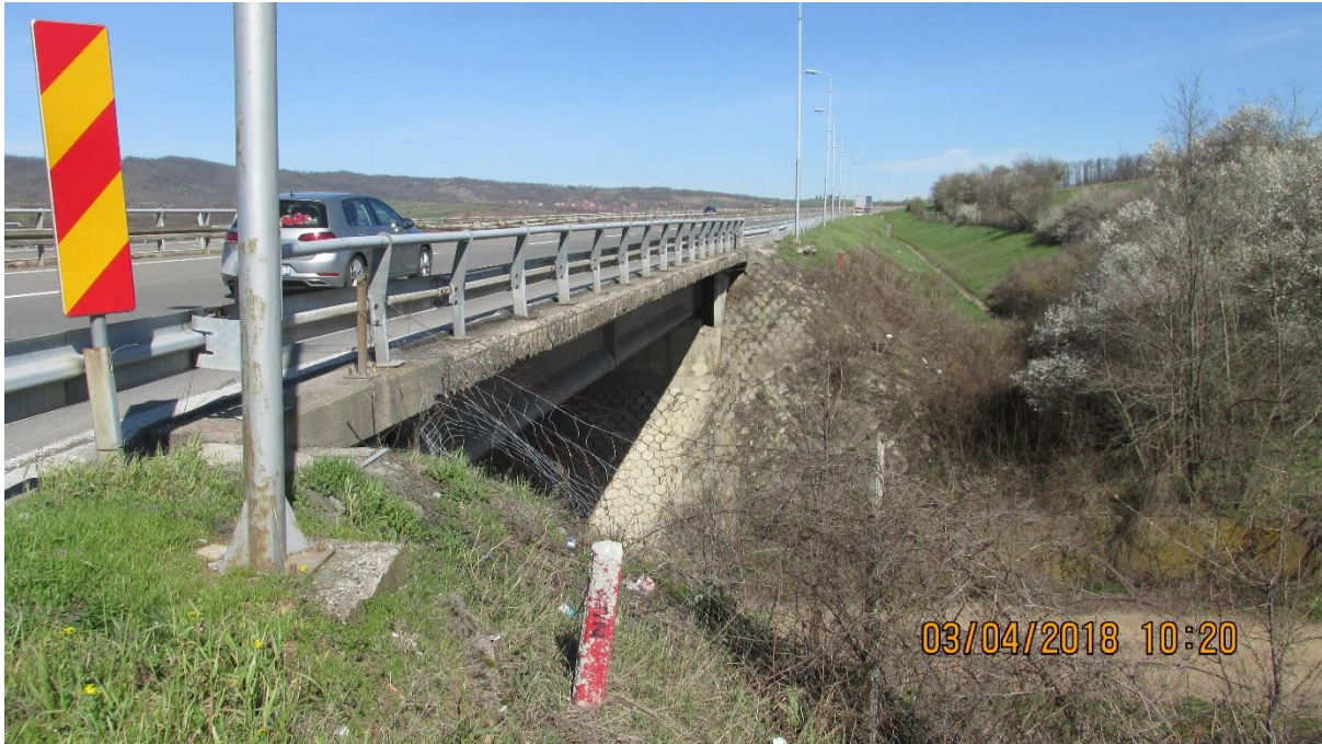
Слика 27. Мост преко пута Ђунис – Ражањ на км 389+947
