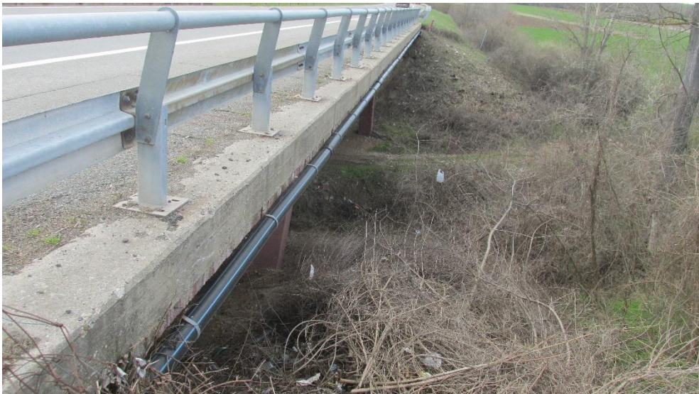
Слика 19. Мост преко Дреновачког потока на км 394+029
