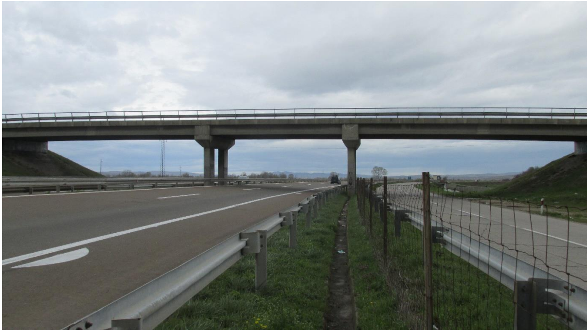
Слика 32. Надвожњак на км 407+625
