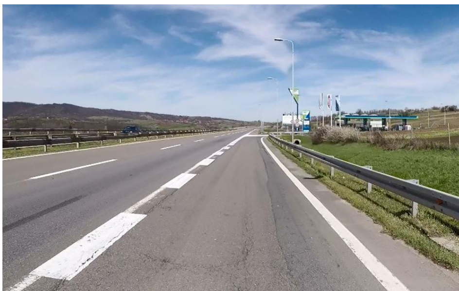
Слика 11. Бензинске станица „ОМВ“ на км 390+100
