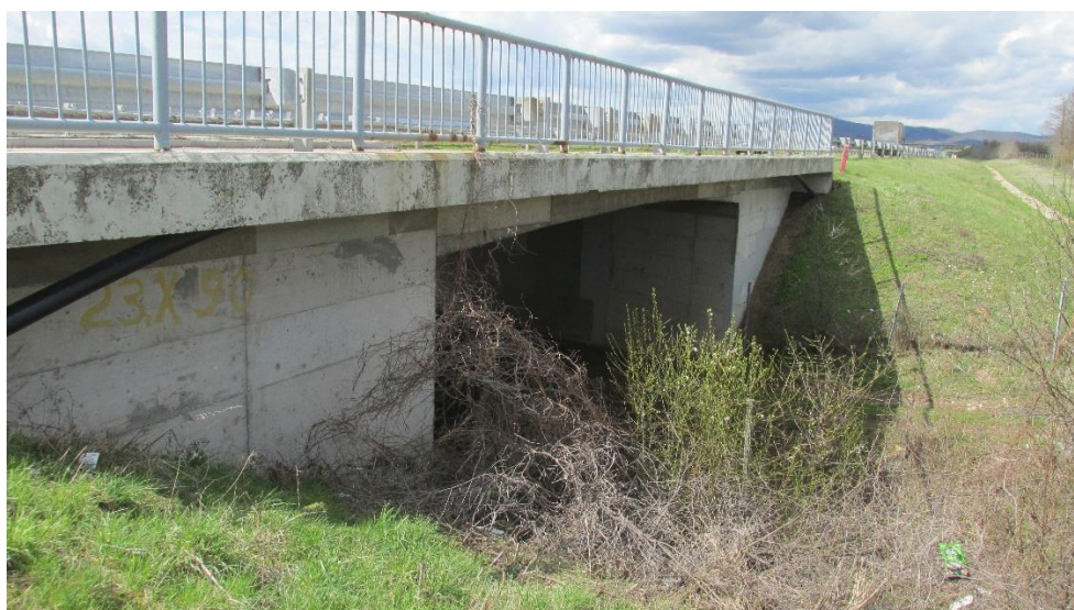
Слика 20. Мост преко Сувог потока на км 396+525
