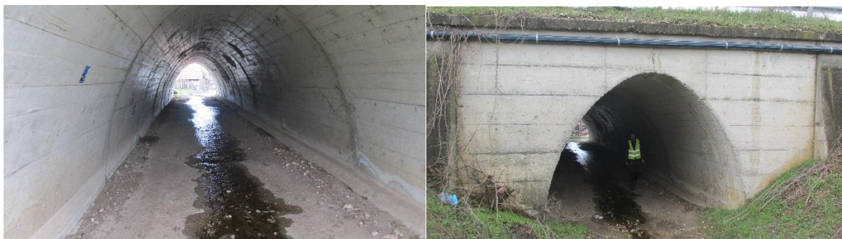
Слика 23. Засведен пропуст на км 402+203
