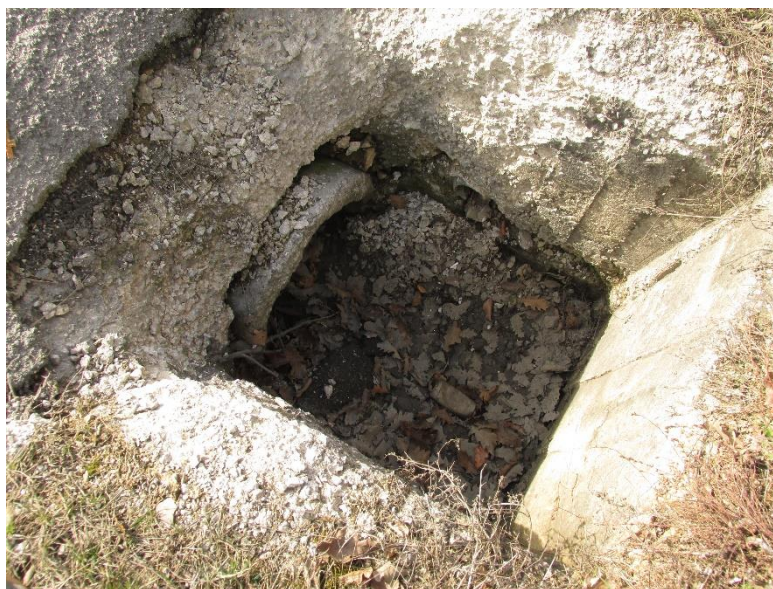
Слика 31. Пример уливне грађевине цевастог пропуста на км 192+612
