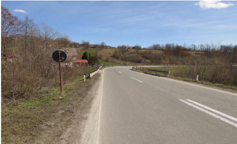
Слика 26. Мост преко реке Ненадковице код Тубића на км 188+094
