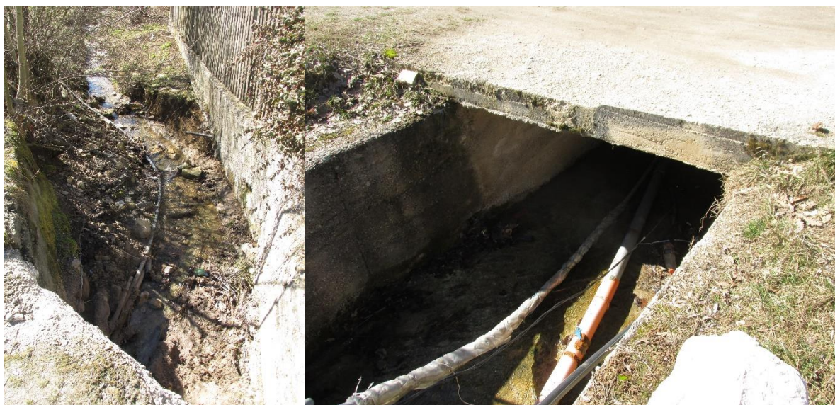
Слика 34. Плочасти пропуст на км 188+750
