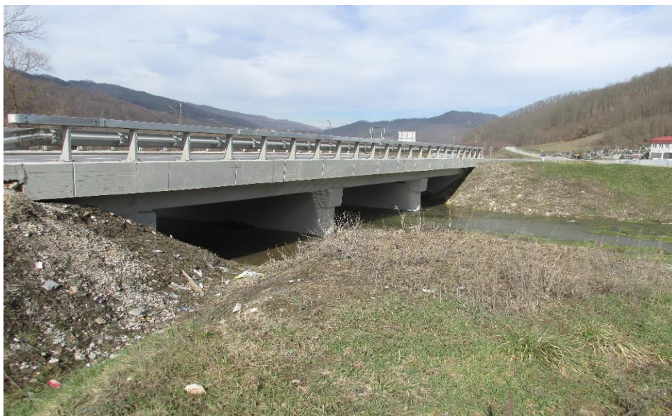
Слика 29. Мост преко Добрињске реке на км 198+247
