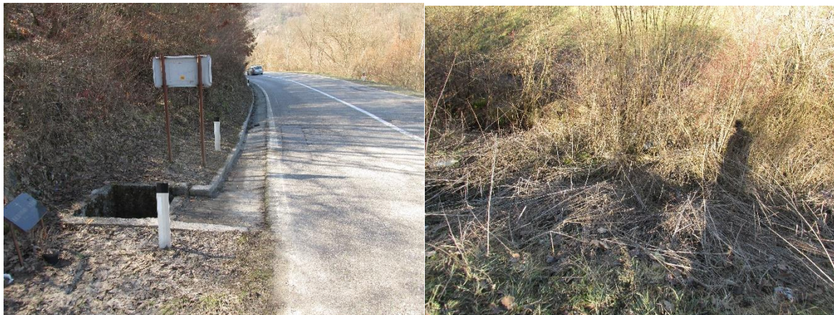
Слика 30. Уливна грађевина цевастог пропуст у риголу, десна (изливна) глава обрасла растињем
