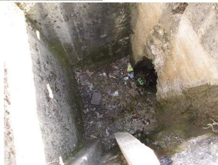
Слика 33. Комбиновани пропуст на км 185+413
