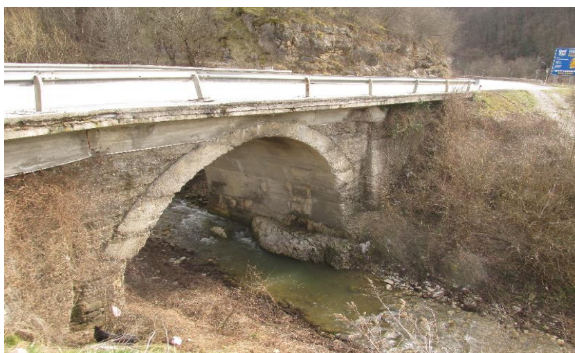
Слика 28. Мост преко потока код градња код Каленића на км 192+886
