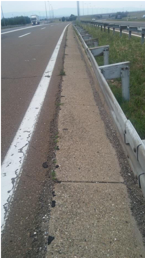
Слика 11. Бетонски ригол уз разделни појас
