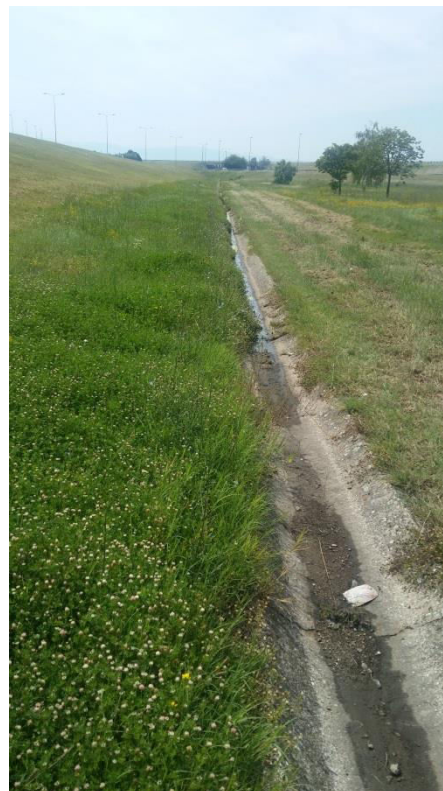
Слика 4. Јарак са бетонском облогом
