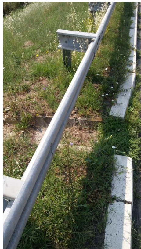
Слика 8. Излив са коловоза у бетонске корубе
