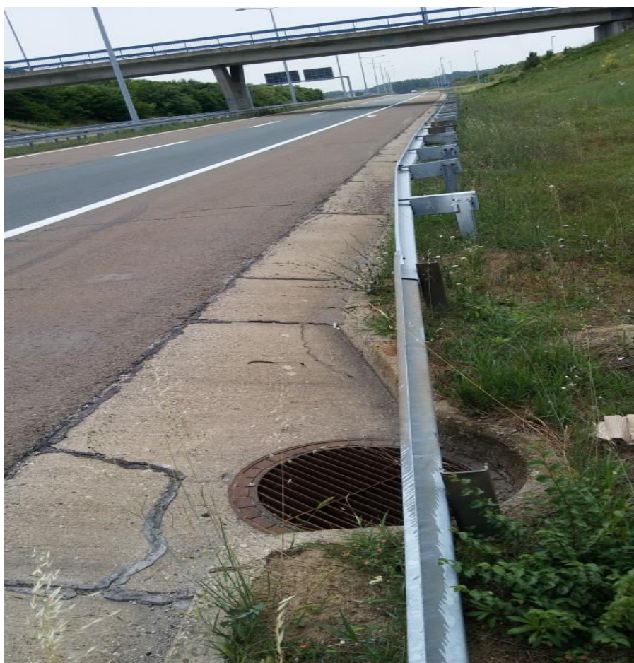
Слика 13. Улив ригола у шахт преко решетке уз десну ивицу коловоза (петља Мерошина)
