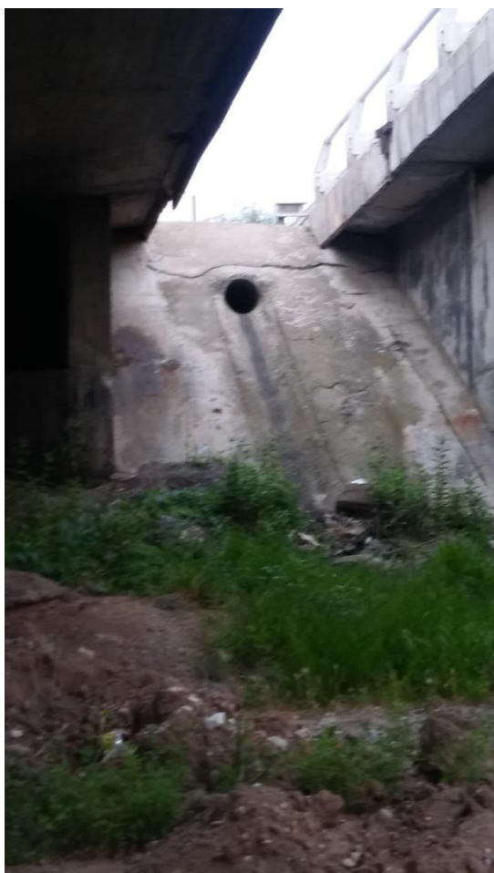
Слика 14. Излив зацевљеног система низ бетонско слапиште
