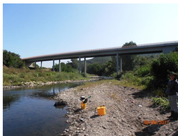
Слика 29. Мост преко реке Топлице
