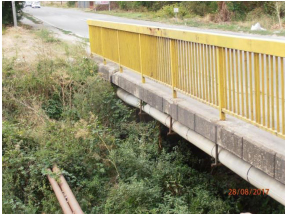
Слика 3.13 - Мост преко Крајковачке реке
