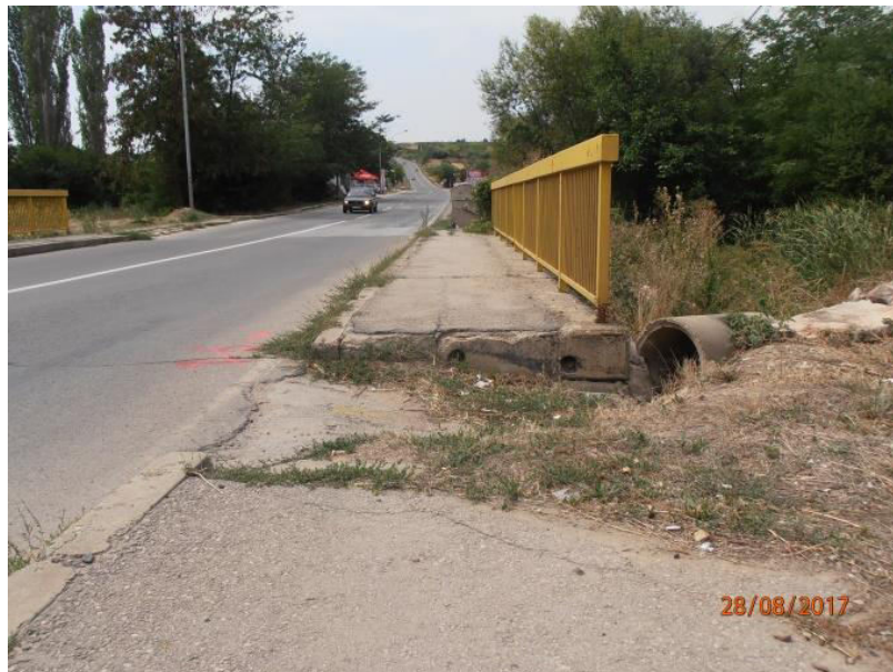
Слика 1.5 - мост преко Крајковачке реке
