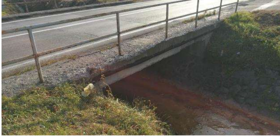
Слика 11 и 12: Мост преко потока код ибарског рудника (стац. км 221 + 416)
