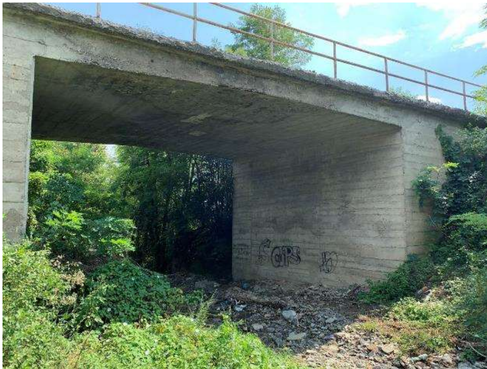
Слика 13: Мост преко потока у Баљевцу (стац. км 222+184)
