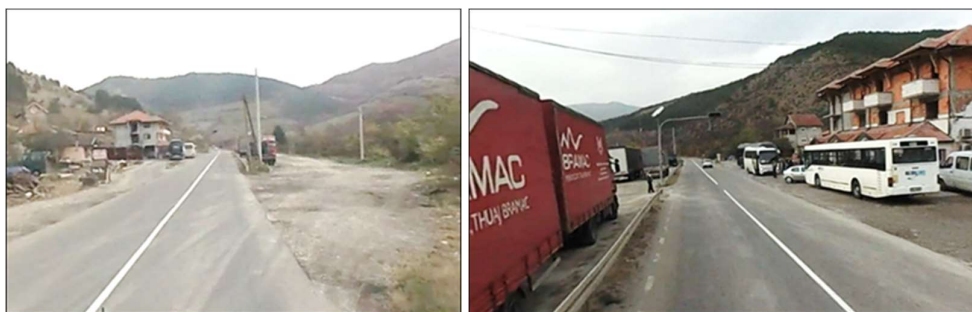
Слика 32: Неуређен паркинг простор поред државног пута-угоститељски објект „Фонтана“
