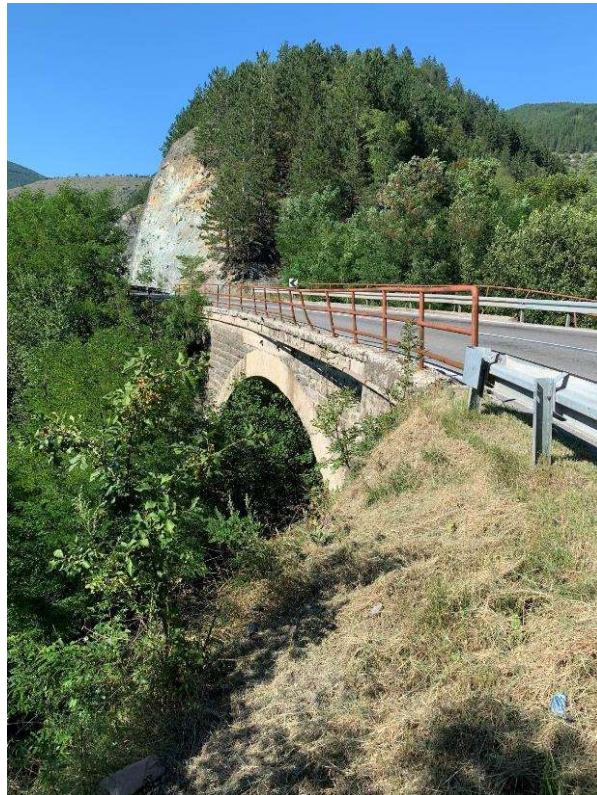
Слика 7: Мост преко потока у Барама (стац. км. 210+638)
