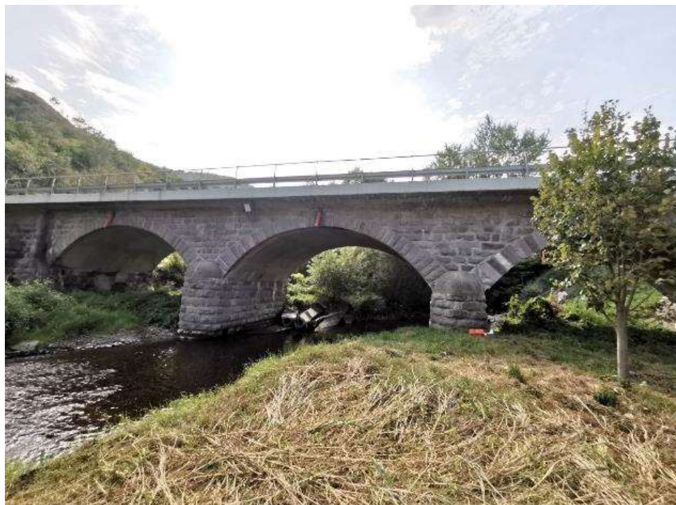
Слика 14: Мост преко реке Брвенице (стац. км 226+760)
