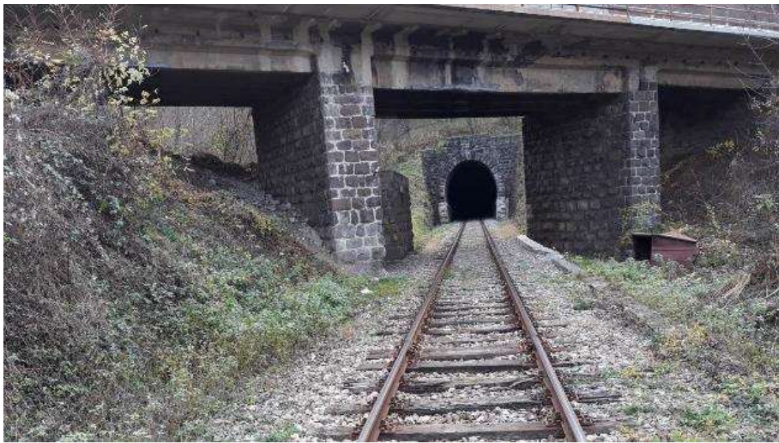
Слика 9: Мост преко пруге у Бојанићима (стац. км 213 + 194)
