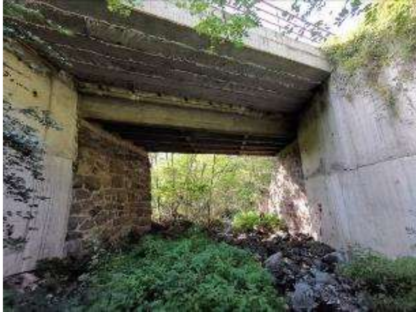
Слика 8: Мост преко Марковске реке (стац. км 212 + 229)
