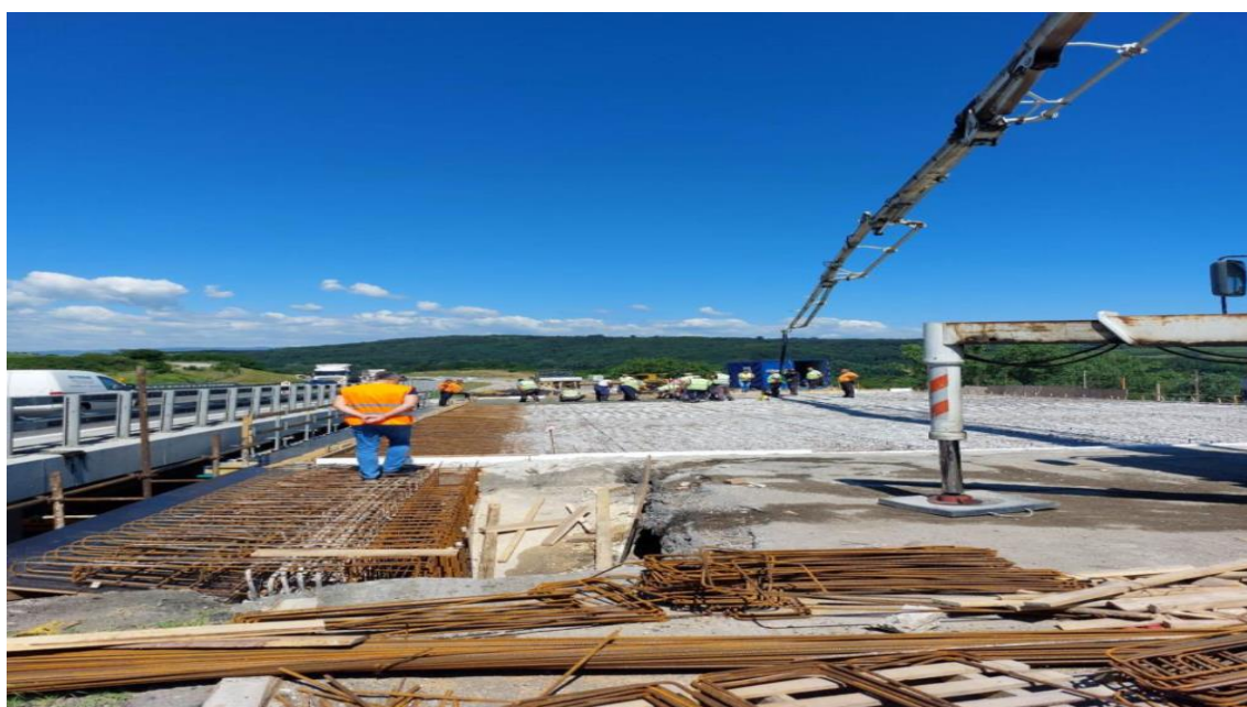
РАДОВИ НА РЕХАБИЛИТАЦИЈИ МОСТОВА
