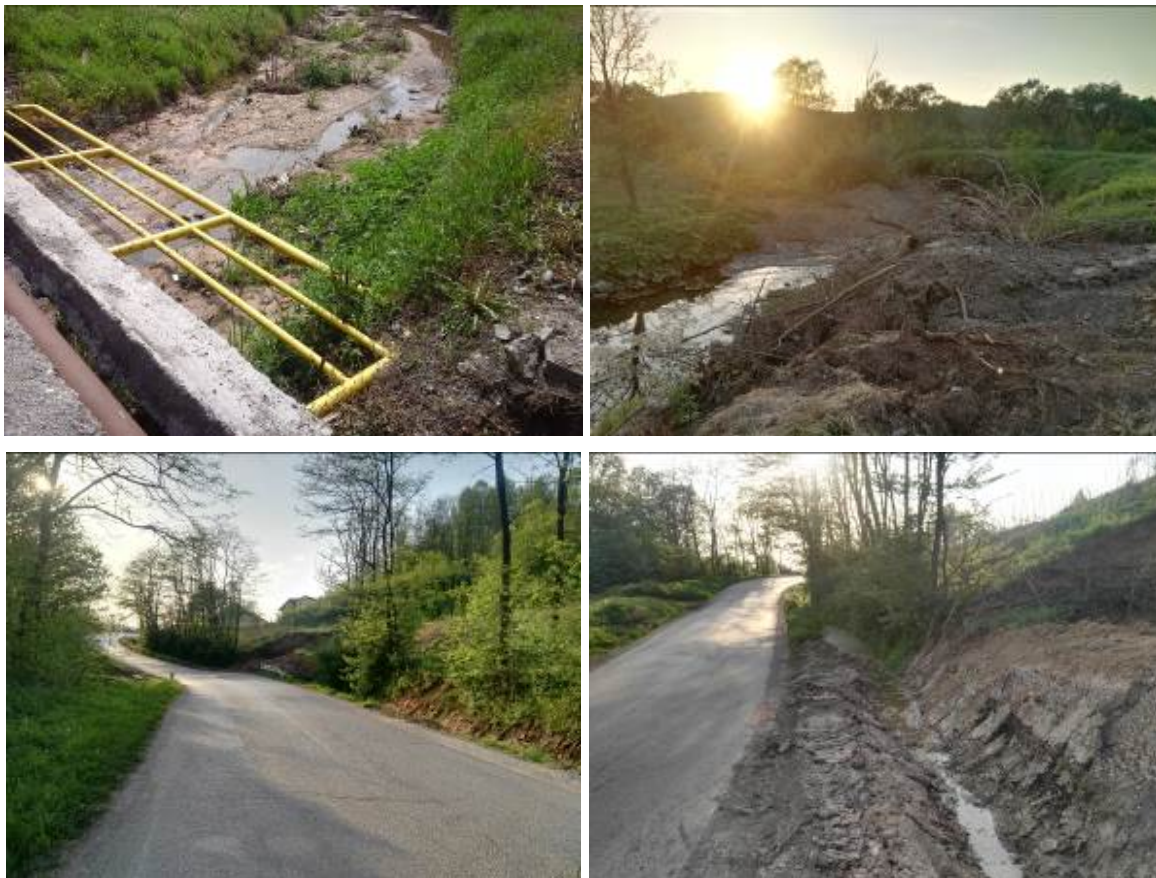
Слика 15 - Неуређеност корита тока и путних канала
