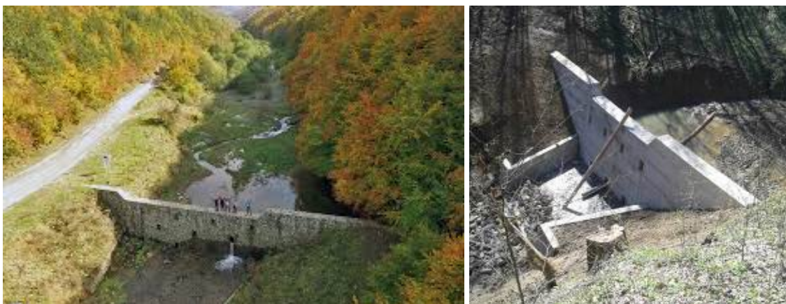
Слика 25 - Бујичне преграде од камена у цементном малтеру и од бетона
