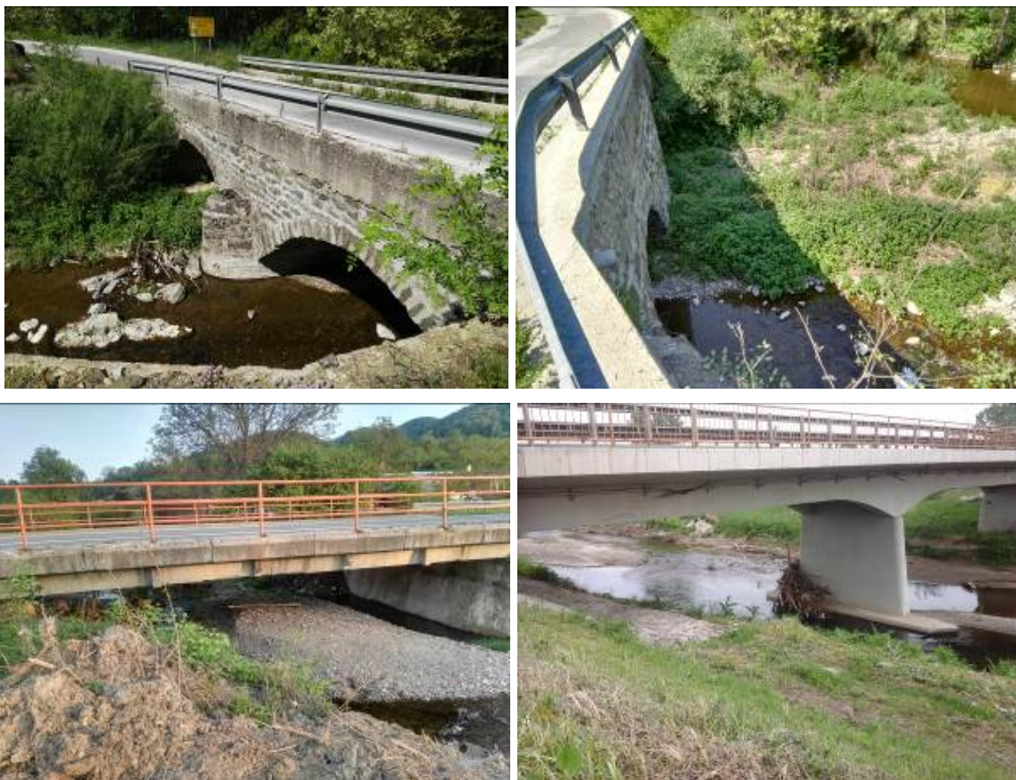
Слика 16 - Смањена пропусна моћ мостова и пропуста
