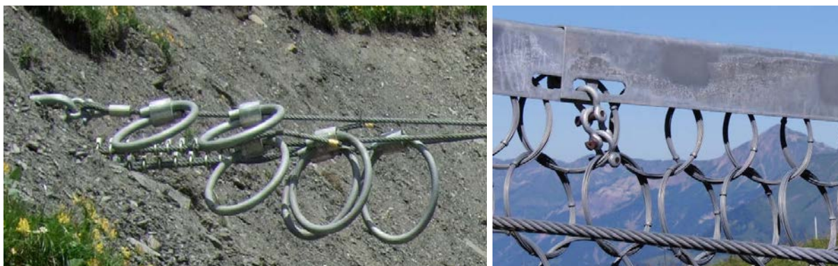
Слика 31 - Кочиони прстенови и заштитни L профили од челика
