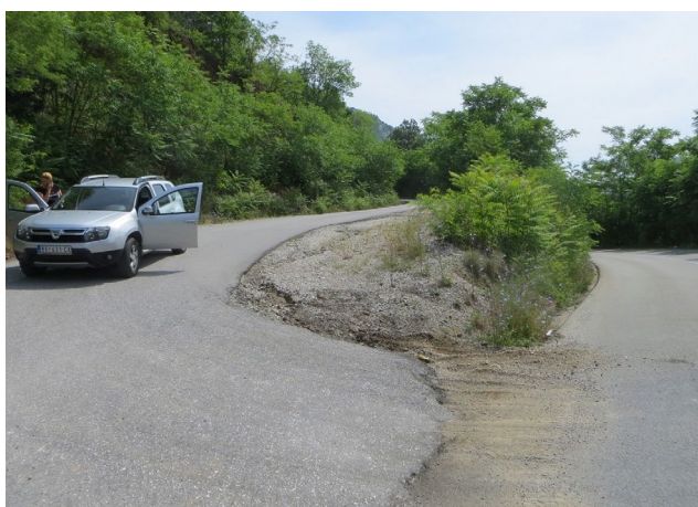
Слика 16 - Деонице пута без система за спровођење кишног отицаја
