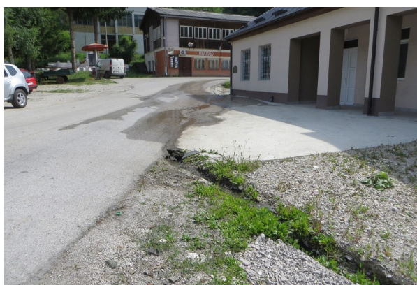
Слика 34 - Предлог 4 – L301 на путу IIA реда (ознака пута 194, Кокин Брод (Прибојска Бања) - Прибојска Бања). Задржавање воде на путу.
