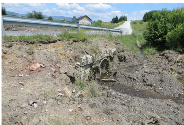
Слика 33 - Предлог 3 - L132 на путу IV реда (ознака пута 29, Аљиновићи - Сјеница). Урушавање косине пута услед изостанка обезбеђења.
