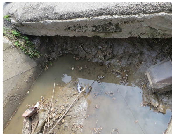
Слика 15 - Смањен протицајни профил за 70% услед велике количине наноса
