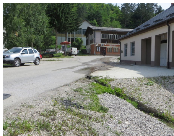
Слика 16 - Деонице пута без система за спровођење кишног отицаја
