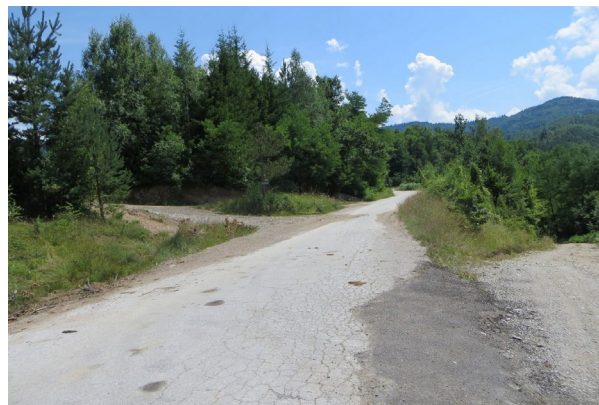
Слика 38 - Предлог 8 – локација 243 на путу IIА реда (ознака пута 192, граница ЦГ/СРБ (Чемерно) - Саставци). Са споредног пута слива се велика количина наноса на главни пут.
