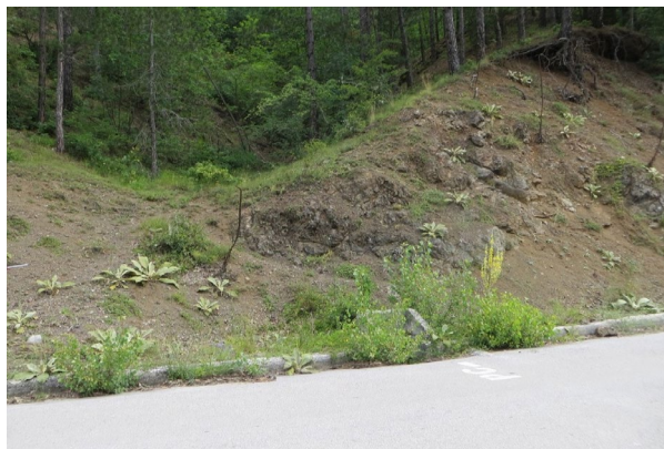
Слика 37 - Предлог 7 – локација 336 на путу IIА реда (ознака пута 194, Прибој - Саставци). Јаруга без дефинисаног корита разлива се низ падину.
