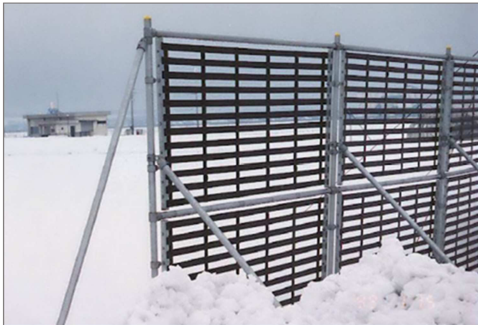
Слика 7.9 Заштитна конструкција са PARAWEB мрежом
