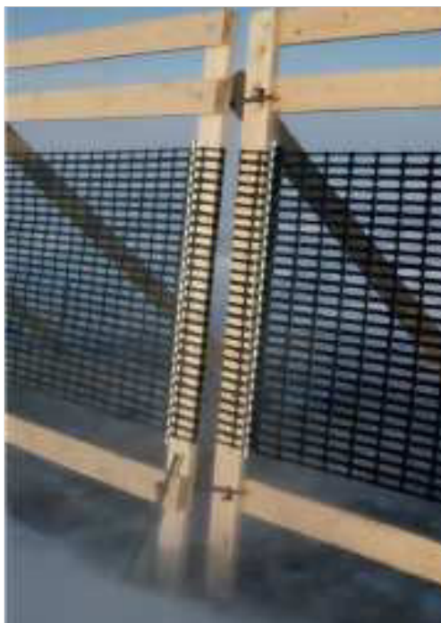
Слика 7.10 Заштитна конструкција „TENSAR“
