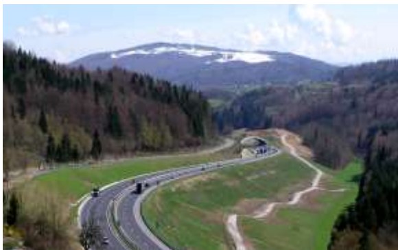
Slika 7.5.1: Primer oblikovanja reljefa u zemljišnom pojasu i iznad pokrivenog useka u skladu sa prirodom
