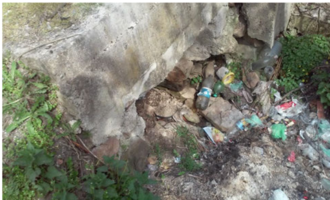
Слика 10: Пример смањења пропусне моћи пропуста и потребе за санацијом
