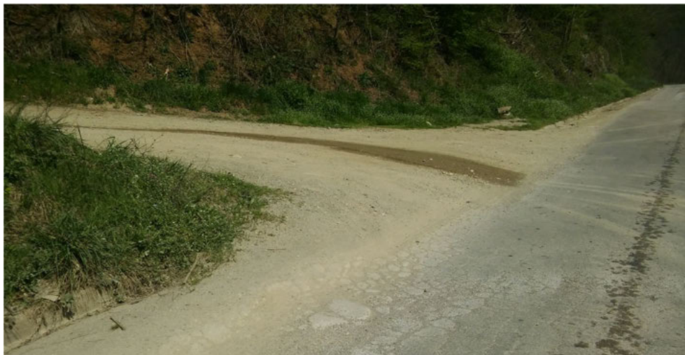
Слика 5. Пример оштећења на деоници – нанос земљаног материјала
