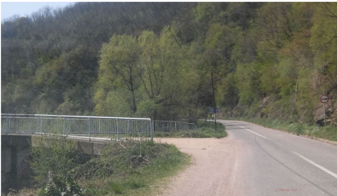
Слика 7. Прикључак са моста. Велике количине земљаног наноса на коловозу
