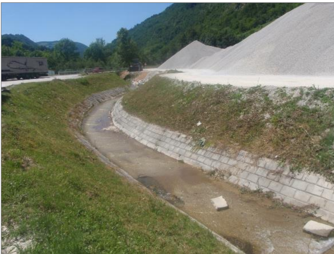
Слика 7 - Регулисано корито реке Козлице у зони каменолома
