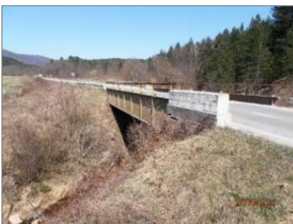
Слика 41 - Мост преко потока у Марковићима
