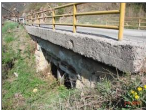
Слика 37 - Мост преко брдског потока
