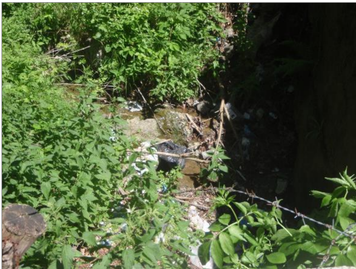
Слика 13 - Пропуст обрастао растињем и смеће
