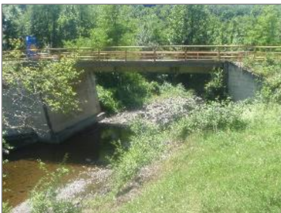
Слика 39 - Мост преко Буковске реке у Бачевцима
