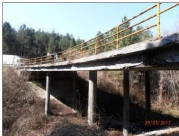
Слика 40 - Мост преко потока (Мрчића мост)
