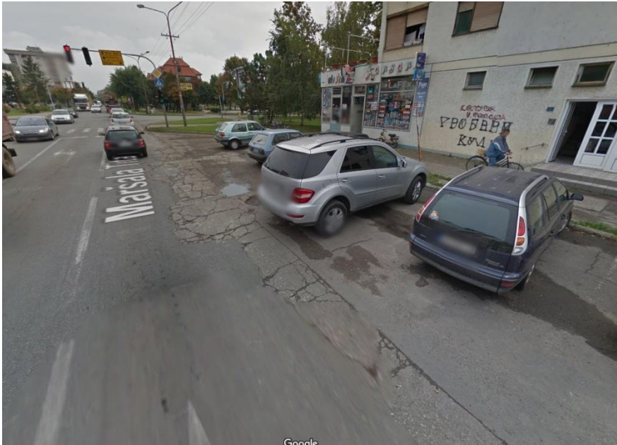
Слика 16. Постојеће стање коловоза - различите коловозне конструкције
