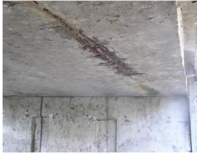
Процуривање између првог и другог носача.
