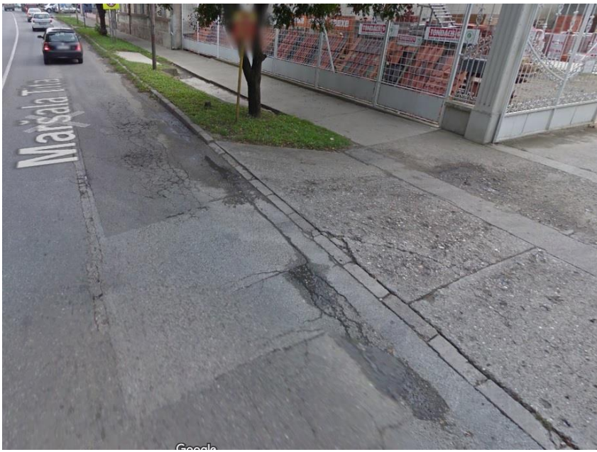
Слика 15. Пример оштећења на деоници
