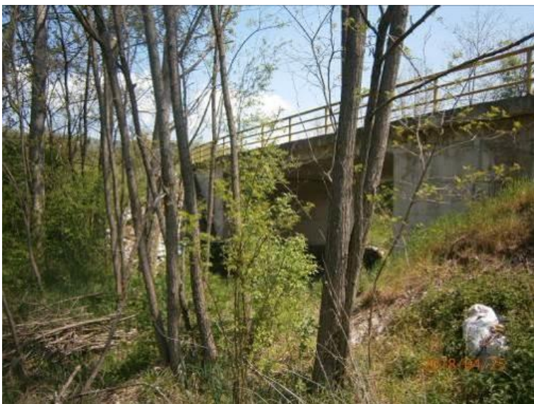
Слика 13: Мост преко реке Рђавице (Укрштај бр. 7)
