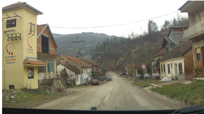
Слика 26. Постојеће аутобуско стајалиште- Љуберађа на кт 31+028
