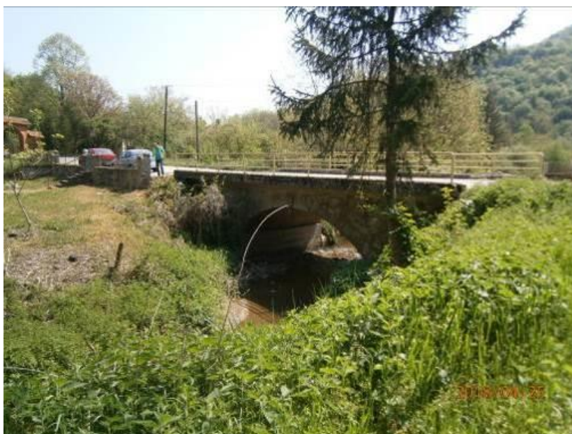
Слика 15: Мост преко реке Рђавице (Укрштај бр. 9)
