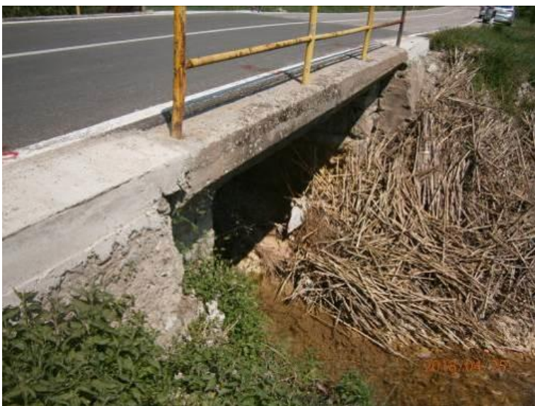
Слика 9: Плочасти пропуст преко реке Линовиштице
