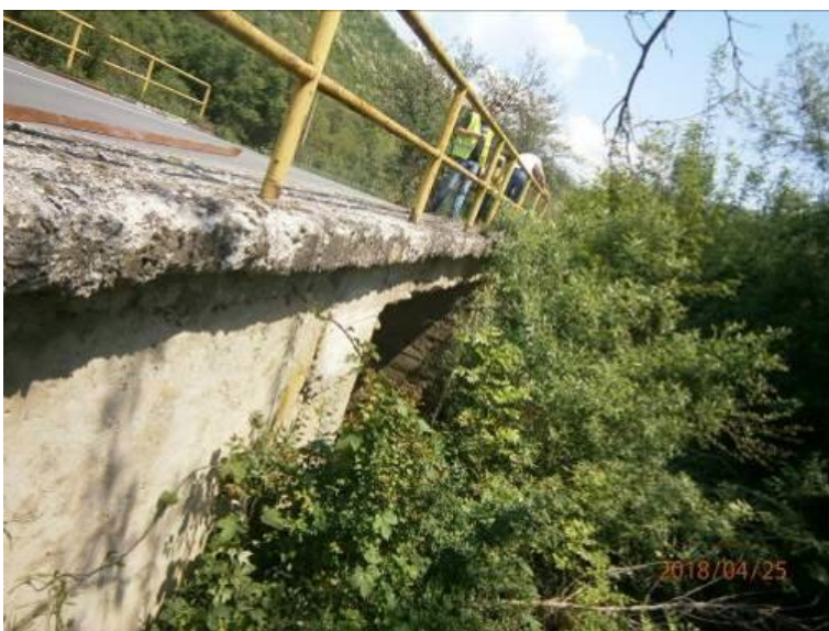
Слика 11 : Плочасти пропуст преко Брестовдолског потока
