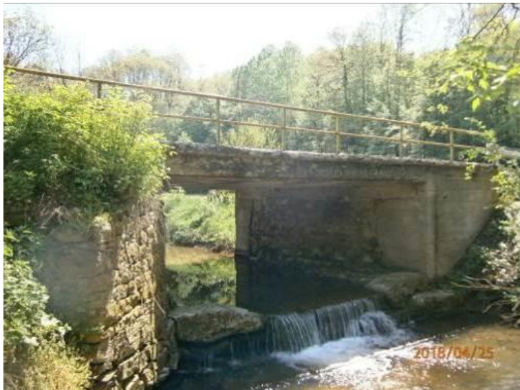
Слика 14 : Мост преко реке Рђавице (Укрштај бр. 8)
