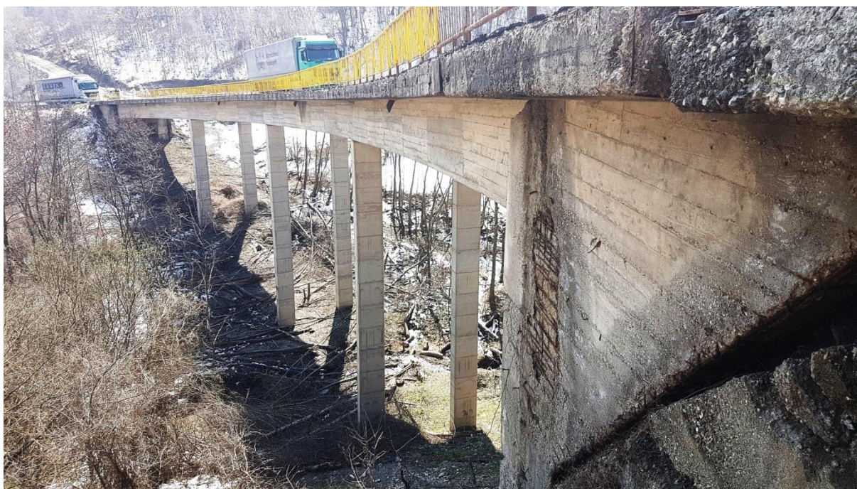
Поглед на мост „Орље“
