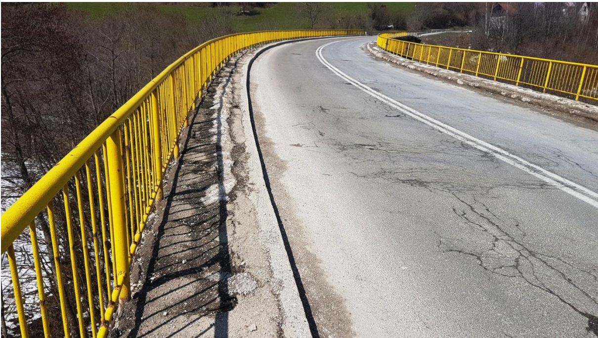
Коловоз на мосту „Орље“
