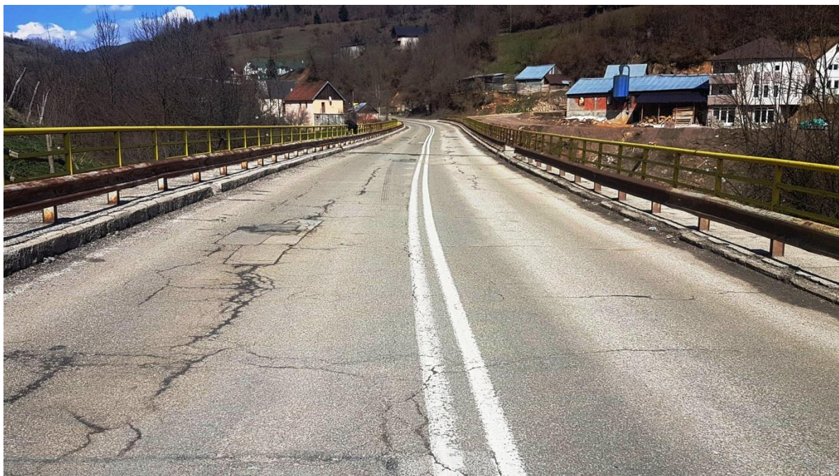
Коловоз на мосту „Шпиљани“
