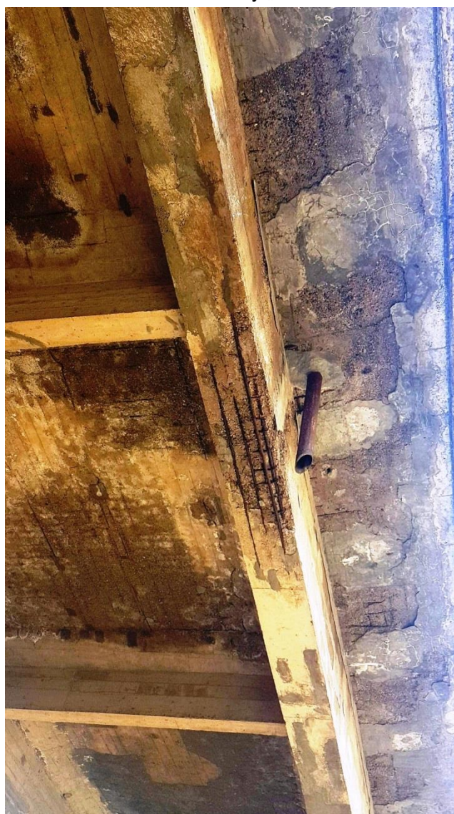
Знатна оштећења бетона на свим деловима конструкције
