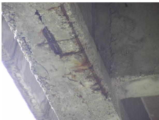
Корозија арматуре и одваљивање бетона
