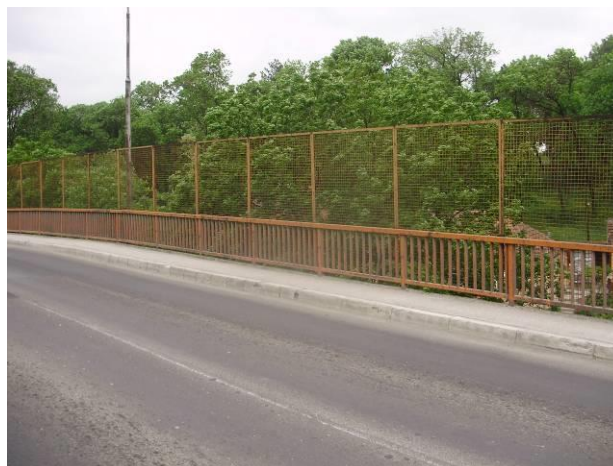
Заштитна ограда изнад пруге
