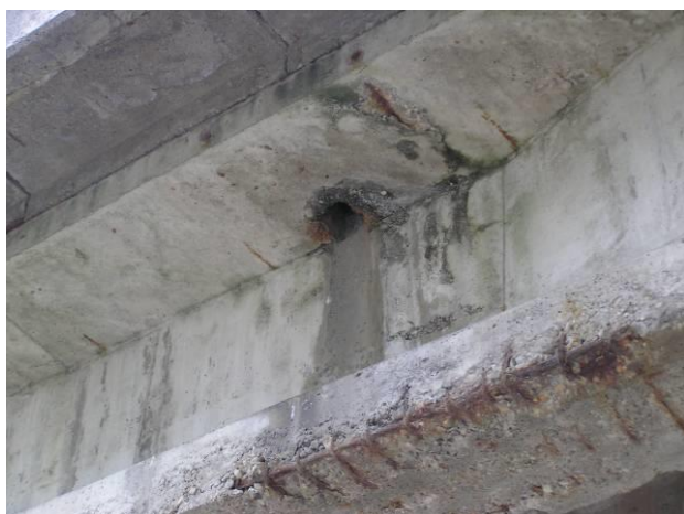
Отвор за монтажу из простора за инсталација расвете
