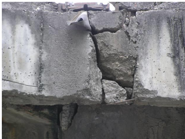
Оштећење конзоле пешачке стазе код дил. –S1
