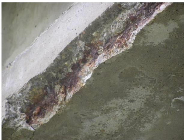
Прекид арматуре на ивици
