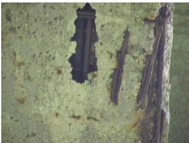
Бетонско гнездо око кабла за преднапрезање
