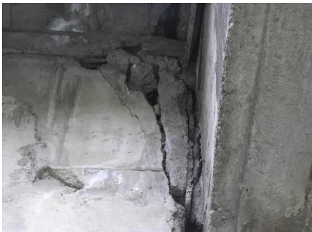
Оштећење краја ивичног носача- стуб S1
