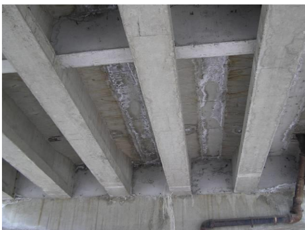
Продори воде кроз коловозну плочу и калцификација
