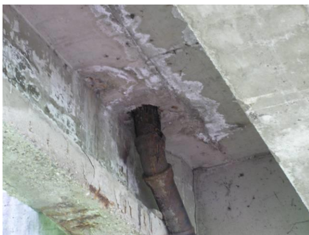
Продори воде кроз коловозну плочу и калцификација
