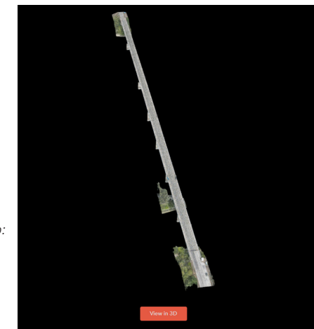
Модел моста Ердут – Богојево - овај ЗД скуп података приказује мост у геореференцираном ЗД окружењу, са детаљним приказом конструкцијских елемената, укључујући коловозну конструкцију, стубове и упорњаке. Погодан је за прелиминарни преглед, мерење и даљинску визуелизацију од стране пројектних партнера; Извор: Аутор текста
