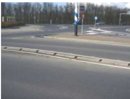
Slika 5.3.60: Razdelno ostrvo trougaonog (levkastog) oblika
