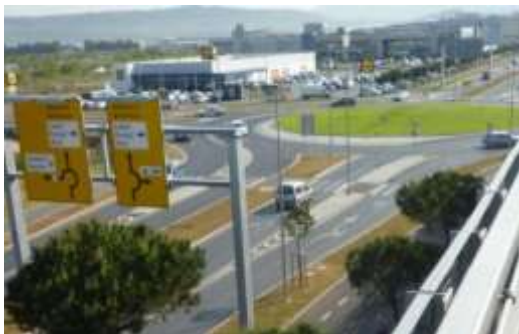
Slika 5.3.62: Razdvajanje ulivnih/izlivnih saobraćajnih traka razdelnim ostrvom
