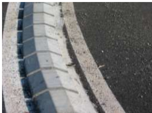
Slika 5.3.72: Detalj elementa za sprečavanje preplitanja u kružnom kolovozu turbo kružne raskrsnice
