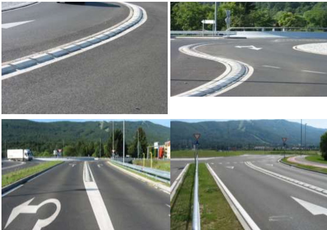
Slika 5.3.73: Detalji elementa za sprečavanje preplitanja u kružnom kolovozu turbo kružne raskrsnice
