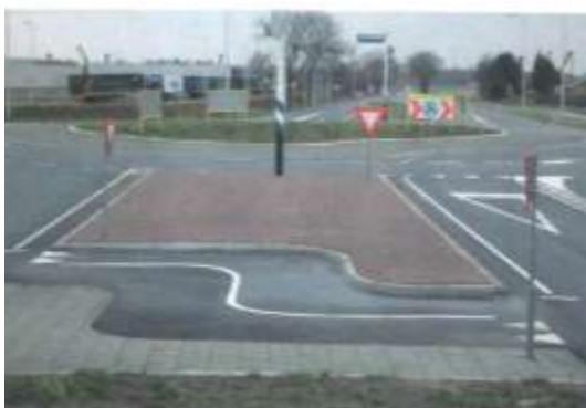
Slika 5.3.51: Primer prelaza za bicikliste preko kraka turbo kružne raskrsnice u Holandiji
