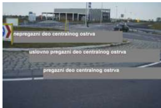
Slika 5.3.63: Delovi centralnog ostrva turbo kružne raskrsnice
