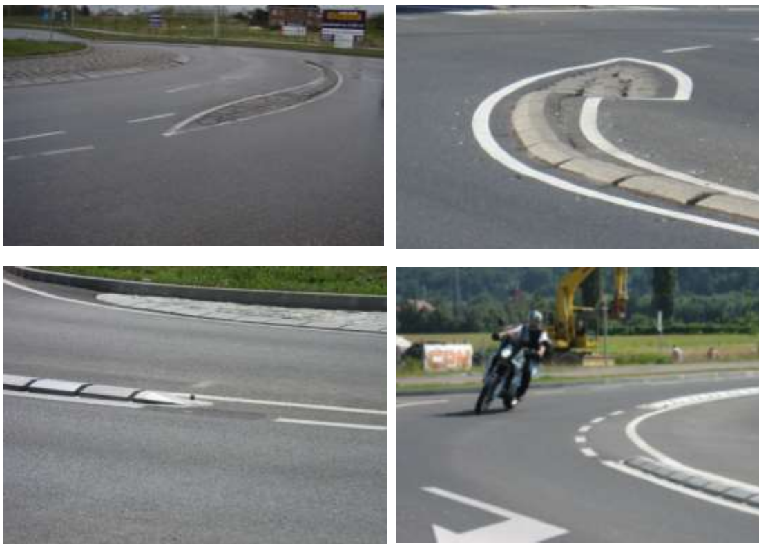
Slika 5.3.74: Detalj početka elementa za sprečavanje preplitanja – „špic“
