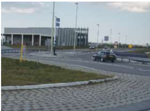
Slika 5.3.70: Postavljanje stubova za svetiljke na razdelnom ostrvu
