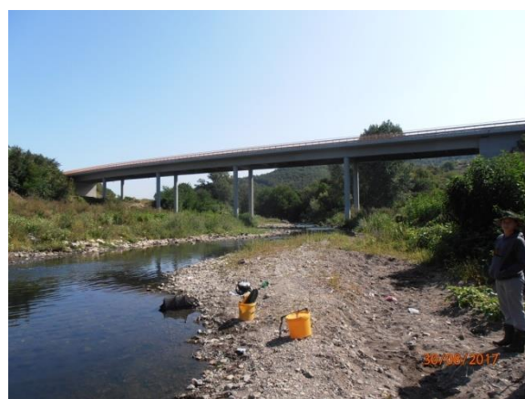
Слика 29. Мост преко реке Топлице
