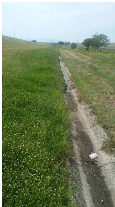
Слика 4. Јарак са бетонском облогом
