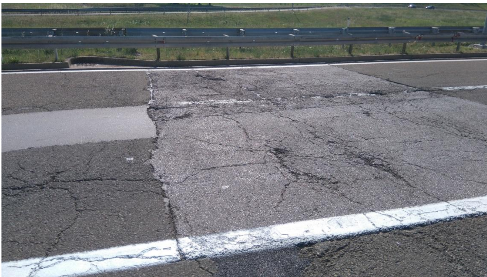
Слика 22. Пример оштећења на деоници
