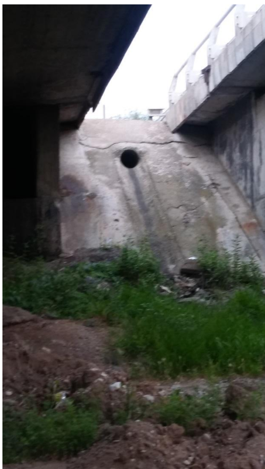
Слика 14. Излив зацевљеног система низ бетонско слапиште
