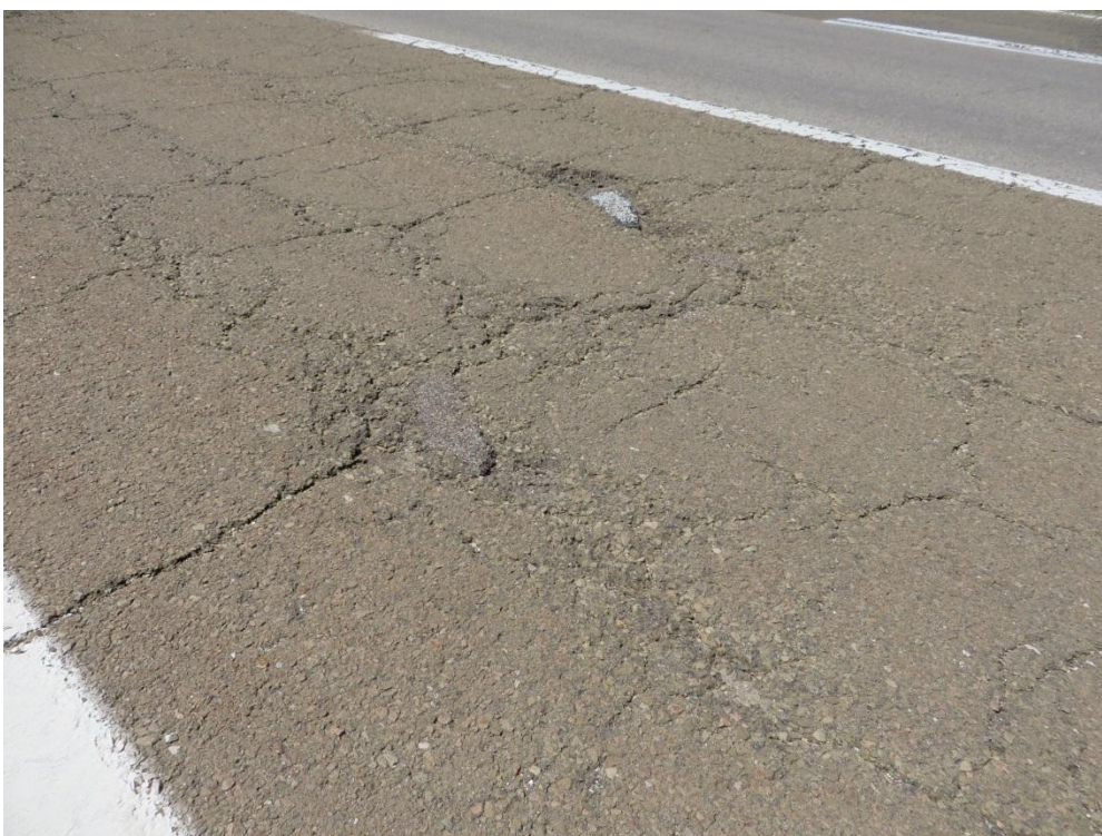
Слика 23. Пример оштећења на деоници
