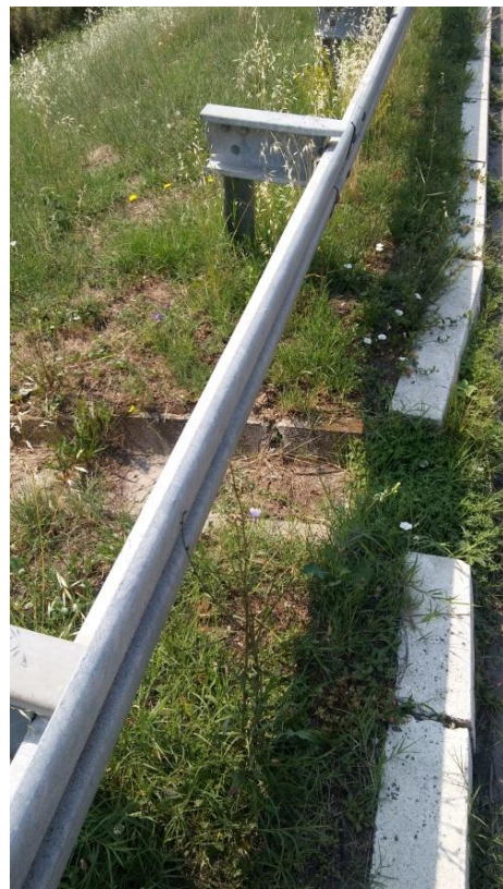
Слика 8. Излив са коловоза у бетонске корубе
