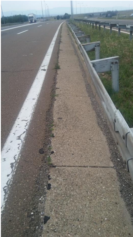
Слика 11. Бетонски ригол уз разделни појас
