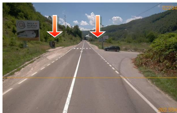
Слика 9. Аутобуска стајалишта на км 262+580 лево (неасфалтирано) и км 262+605 десно (неизграђено)
