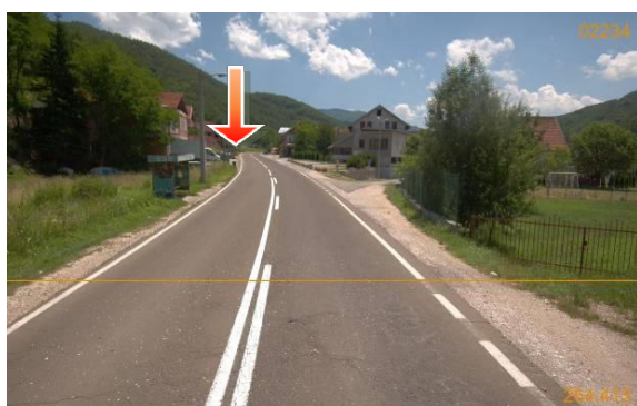
Слика 10. Неизграђено стајалиште на км 264+425
