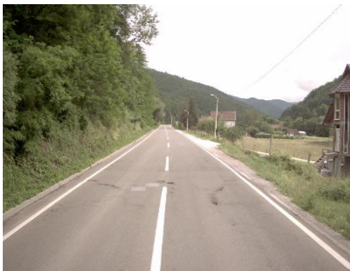
Слика 21. Оштећење коловоза
