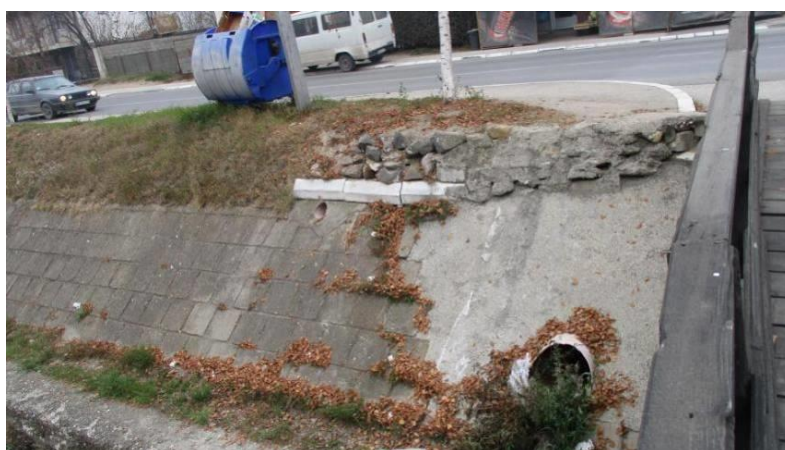
Слика 17. Излив сливника и колектора у реку Јошаницу
