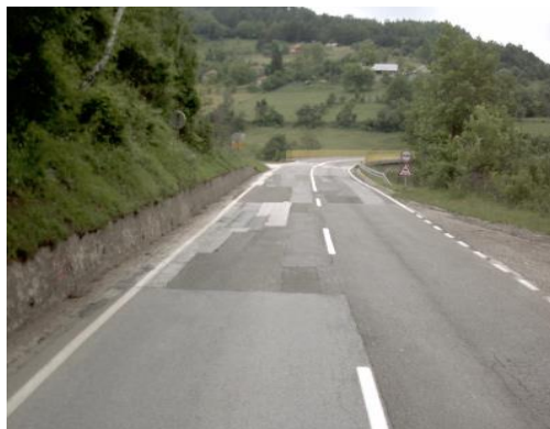
Слика 22. Оштећење коловоза
