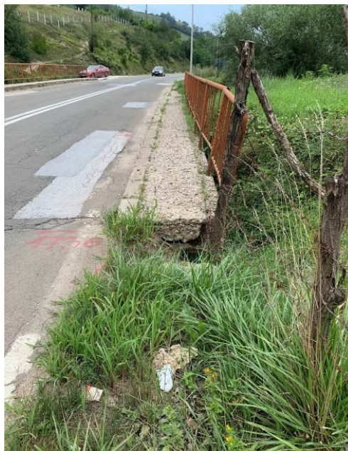
Слика 4. Лоше стање коловоза, пешачких стаза и ограда на мосту
