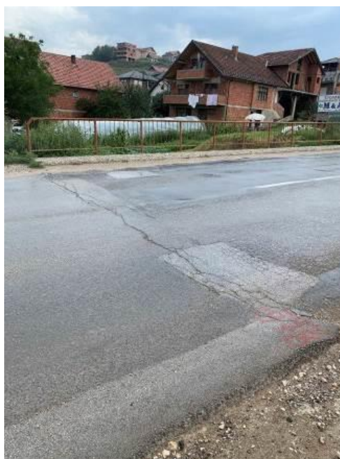
Слика 3. Лоше стање коловоза и пешачких стаза на мосту
