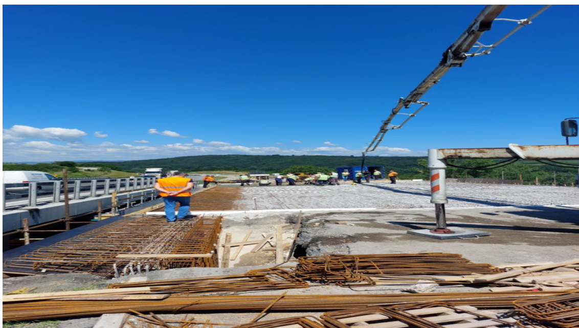
РАДОВИ НА РЕХАБИЛИТАЦИЈИ МОСТОВА
