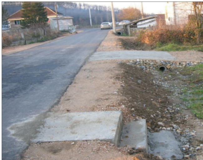
Fotografija 10. Izgradnja lokalnog puta u selu Vračević, opština Lajkovac (Foto: V. Popadić)
