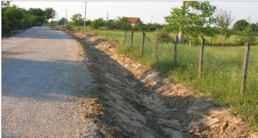
Fotografija 9. Izgradnja lokalnog puta u selu Vračević, opština Lajkovac (Foto: V. Popadić)
