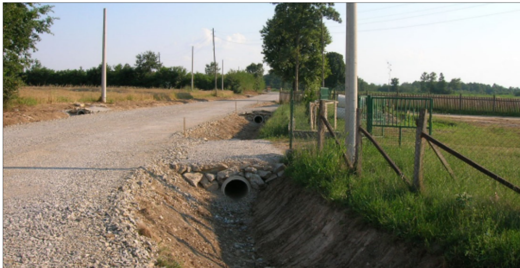
Fotografija 8. Izgradnja lokalnog puta u selu Vračević, opština Lajkovac (Foto: V. Popadić)
