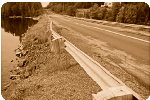
Фотографија 11. Испрана банкина моста
