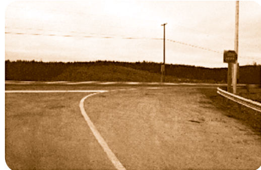
Фотографија 2. Сувише велика удаљеност знака за зауста- вљање (правац 25) на излазном путу
