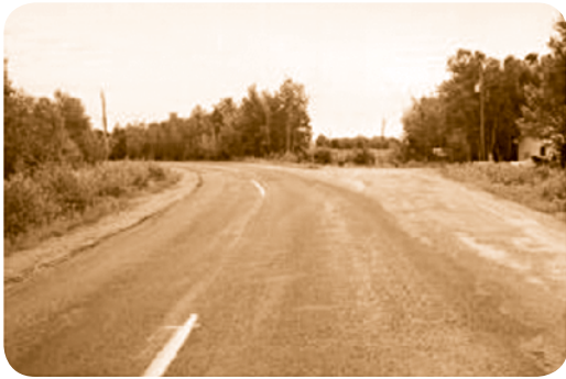
Фотографија 1. Збуњујуће пружање трасе (раскрсница са путем Медисон)
