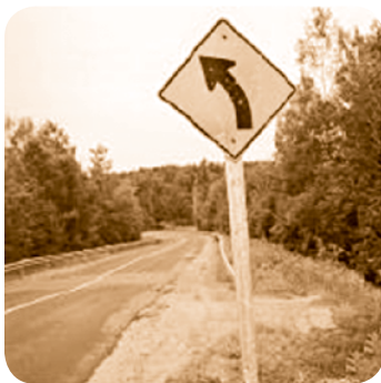
Фотографија 5. Оштећен знак који је изгубио ретрорефлективност
