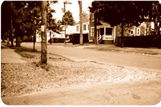
Фотографија 1. Необележени радови на раскрсници
