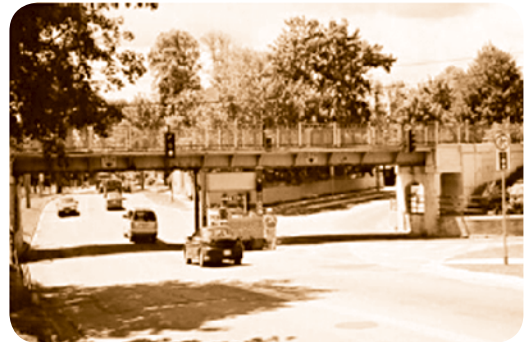
Фотографија 10. Збуњујућа раскрсница
