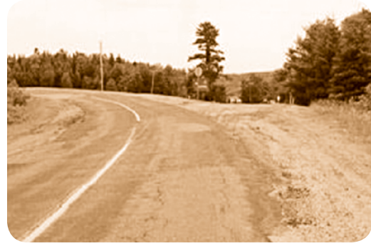
Фотографија 2. Збуњујуће пружање трасе (раскрсница са путем Ројал Парк)
