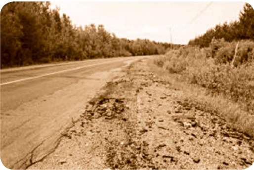
Фотографија 3. Оштећена ивица коловоза
