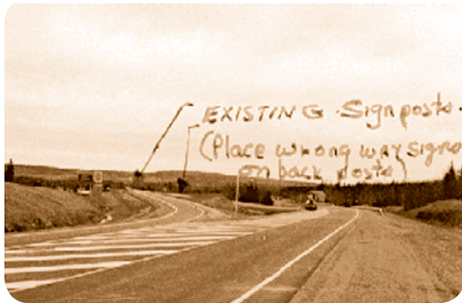
Фотографија 1. Завршетак деонице са западне стране, поглед ка истоку
