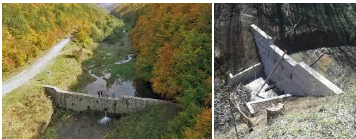
Слика 23 - Бујичне преграде од камена у цементном малтеру и од бетона
