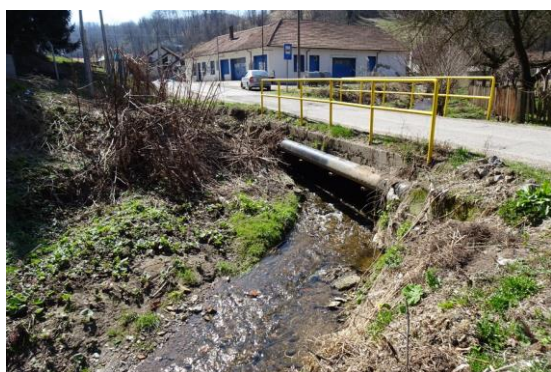
Слика 31 - Предлог 1 – локација 341 на путу IIВ реда (ознака пута 330, Лозница – Зајача). Пример засутости пропуста 70% где се као последица веома често јавља плавлјење пута.
