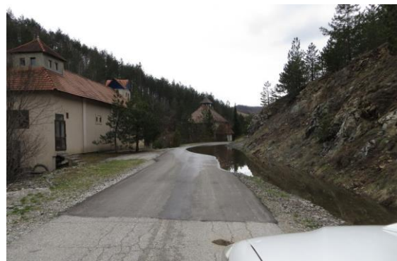
Слика 38 - Предлог 8 – локација 752 на путу IIВ реда (ознака пута 404, Златибор – Семегњево (Железничка станица)). Задржавање воде на путу у дужини око 40 м.
