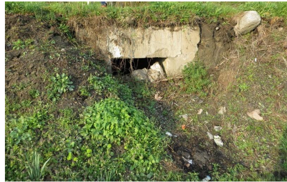
Слика 36 - Предлог 6 – локација 596 на путу IV реда (Љубовија – Рогачица (Дебело брдо)). Оштећен и урушен пропуст.
