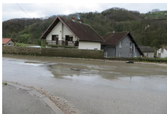
Слика 17 - Деоница пута без система за спровођење кишног отицаја
