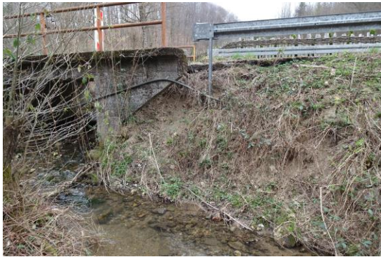
Слика 33 - Предлог 3 - локација 308 на путу IIВ реда (ознака пута 333, Коренита – манастир Трноша). Урушавање косине пута услед изостанка обезбеђења.
