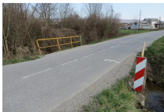
Слика 32 - Предлог 2 – локација 88 на путу IIA реда (ознака пута 138, Липнички Шор – Текериш (Трбосиље)). Корито узводно од пропуста обрасло вегетацијом.
