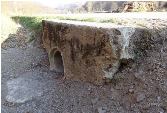
Слика 35 - Предлог 5 – локација 195 на путу IIA реда (ознака пута 143, Причевих – Пецка). Оштећене бочне стране пропуста.
