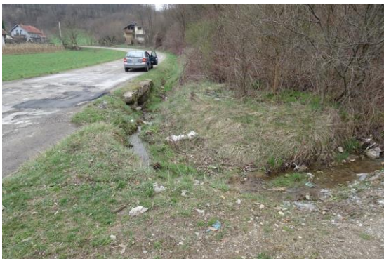
Слика 37 - Предлог 7 – локација 250 на путу IIВ реда (ознака пута 344, Мојковић – Бела Црква (Осечина)). Услед нагомиланог наноса и вегетације измењен смер тока.
