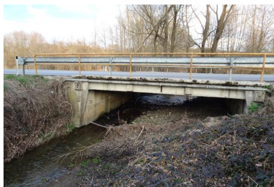
Слика 15 - Смањен протицајни профил за 70% услед велике количине наноса
