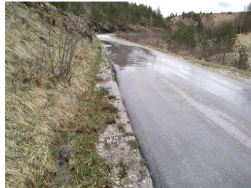
Слика 34 - Предлог 4 – локација 746 на путу IIВ реда (ознака пута 404, Златибор – Семегњево (Железничка станица)). Задржавање воде на путу и ерозија косине због неконтролисаног отицаја
